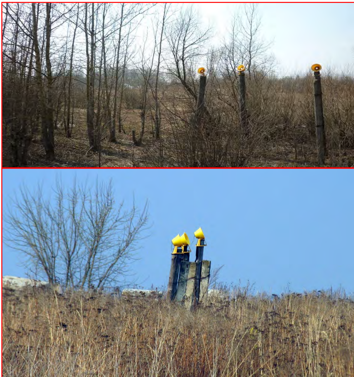
Фот. 21. Установка огней подхода
