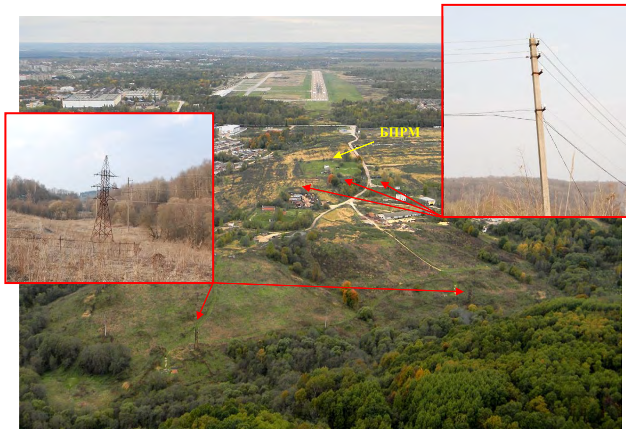
Фот. 17. Расположение линии электропередачи высокого и низкого напряжения по отношению к БПРМ
